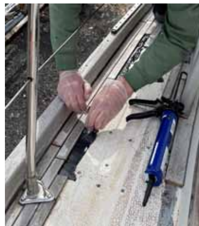
Bild 3 Sikaflex smetas ut med spackelspade. Se till att hela ytan täcks.
