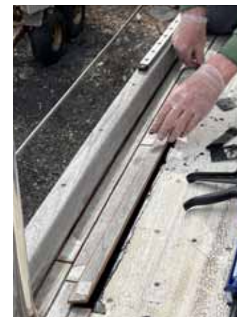
Bild 4 Återläggning av teakribbor.
