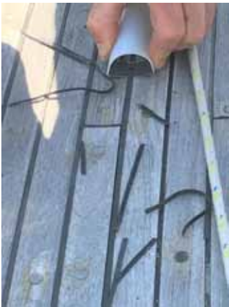
Bild 9 Finjustering av nåten med hemma- gjord nåtkniv med rakblad.
