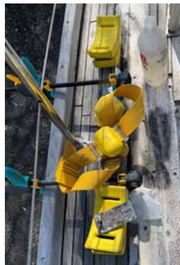
Bild 5 Tyngder för att pressa ner ribborna i sikaflexen. Vid krökta ribbor behövs skruvtingar för att pressa ihop ribborna sidledes.
