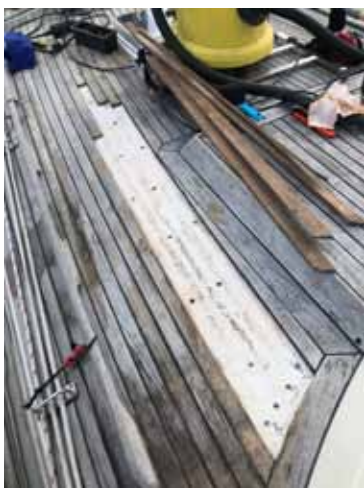
Bild 2 Skruvhålen borras upp och fylls med epoxy.
